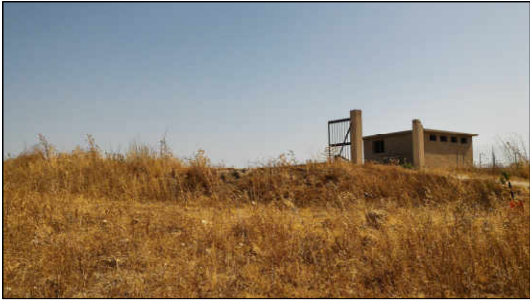
Figura 3: SS1 - Vasca n°1 – Stendimento sismico
